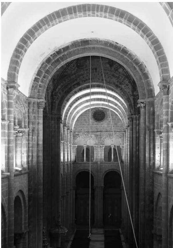
Abb. 3: Querhaus, Blick nach Süden 2008
