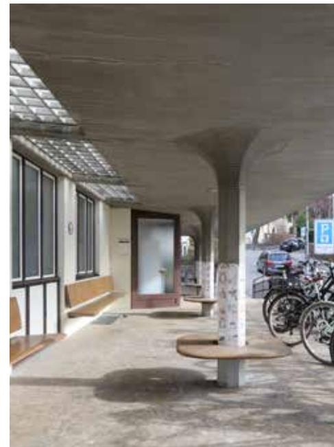
Abb. 44: Die Terrasse mit Pilzstützen am Südflügel an der Poliklinik (2021).
